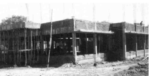
Bâtiment en construction prévu pour accueillir les mères célibataires
