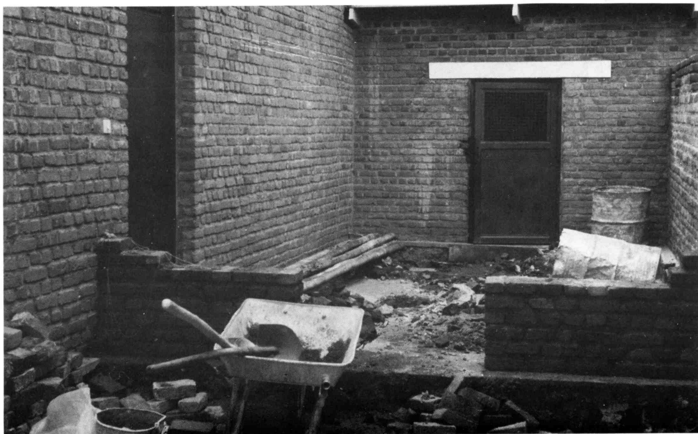
Construction du nouveau bloc sanitaire à côté du dortoir des garçons
