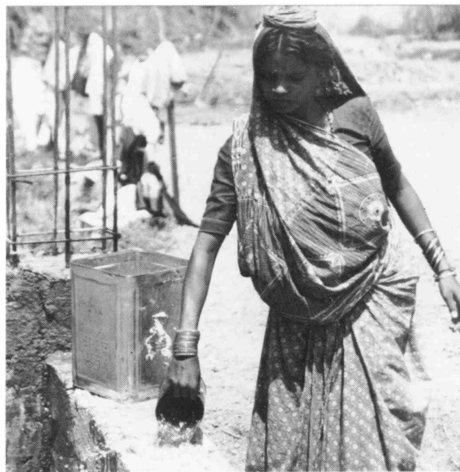
Tant il fait chaud, il faut refroidir le béton pour éviter qu'il ne casse (mars 1991)
