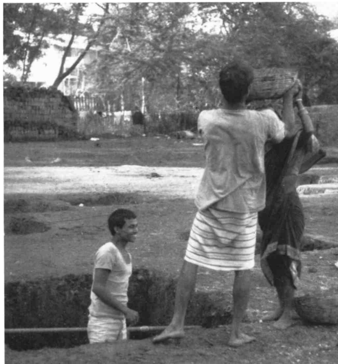
Le début des travaux de la grande nurserie
