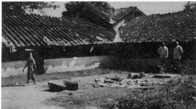
Dallage réalisé aux abords des bâtiments de l'institution (hygiène accrue, possibilité de sortie en période de mousson)
