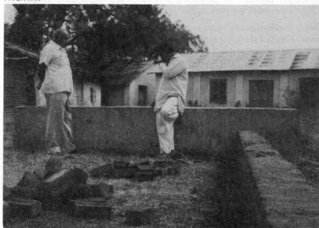
Construction de l'étable pour les bufflonnes
